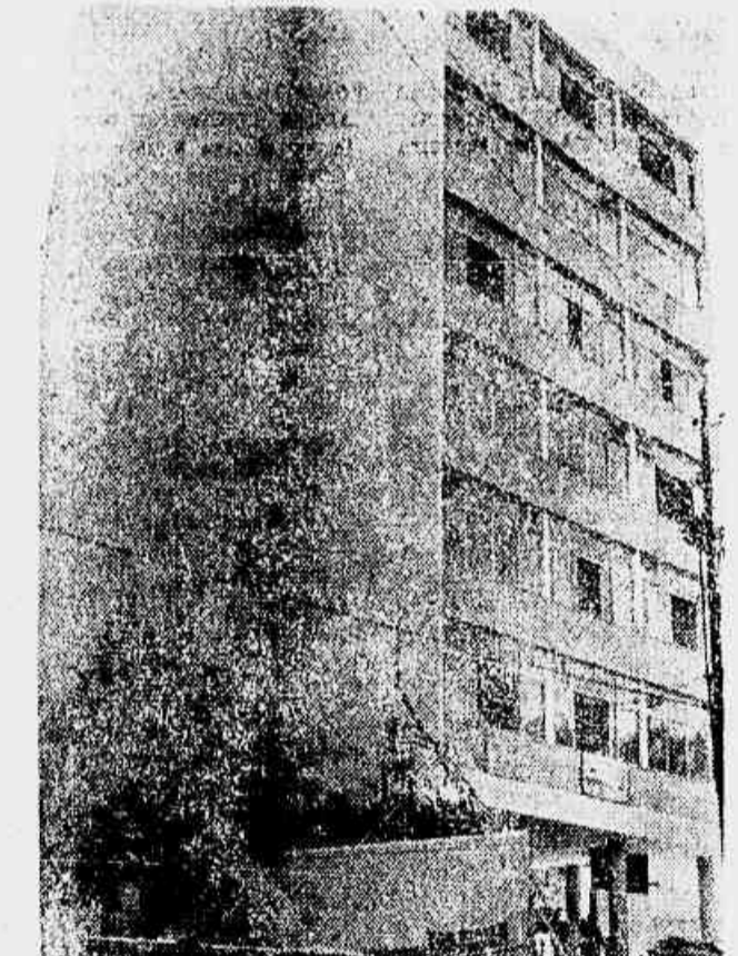
Aspecto do Palácio do Metalúrgico, construído em pleno coração da zona fabril do Distrito Federal, com capacidade para alojar confortavelmente em suas dependências todos os serviços do Sindicato
