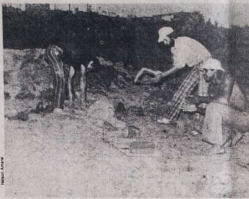
Em mutirão os ocupantes fabricam seus próprios tijolos numa olaria improvisada
